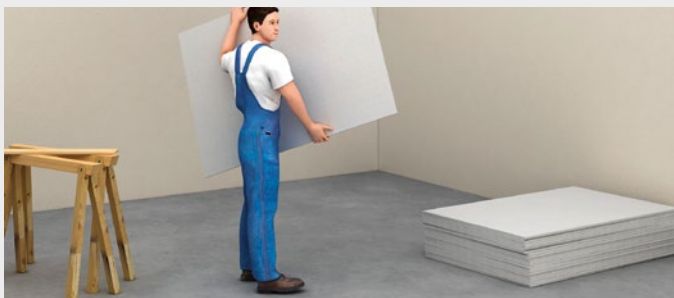
Einzelne fermacell Gipsfaser-Platten hochkant tragen
