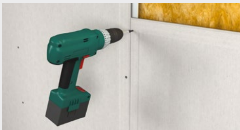
Schrauben auf Stahl-Unterkonstruktion
