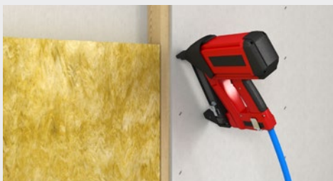
Klammern auf Holz-Unterkonstruktion
