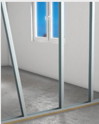
Montage der CW-Ständerprofile
