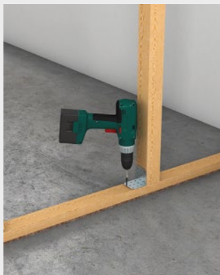
Montage der Holzständer mit Stiftnagel oder Stahlwinkel
