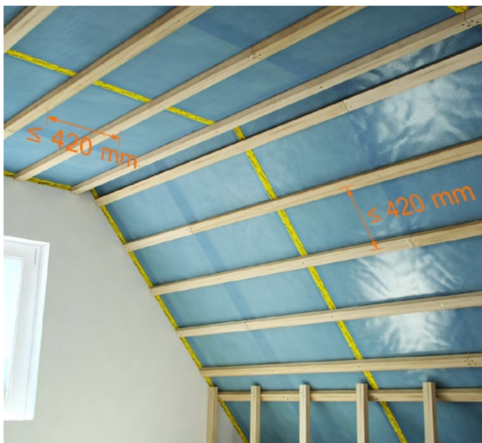
Achsabstände der Holz-Unterkonstruktion
